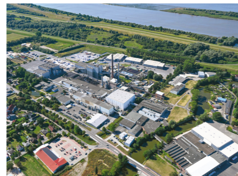
Auf knapp 100 Hektar erstreckt sich die voll integrierte Papierfabrik in Glückstadt. The fully integrated paper mill in Glückstadt extends over almost 100 hectares.
